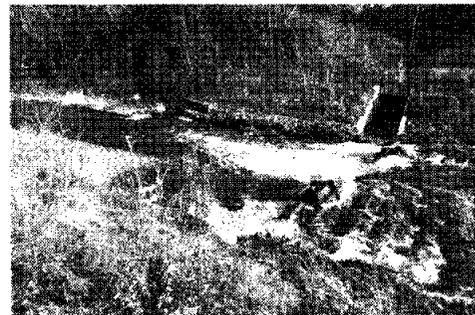
写真2 下流の川岸が崩れている
